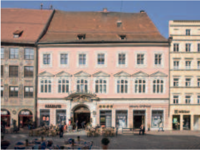
1460 ließ sich der Kanzler Dr. Martin Mair dieses imposante Wohnhaus in der oberen Altstadt erbauen.
